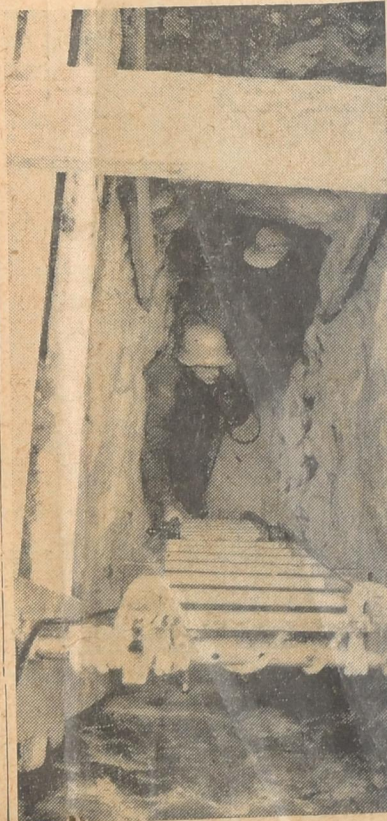
Durch diesen Einstieg erreichten die THW-Männer den letzten noch begehbaren Kellergang.
