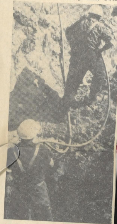
Mit Preßluftbohrern versuchen Arbeiter den Eingang zum Todesstollen freizulegen
