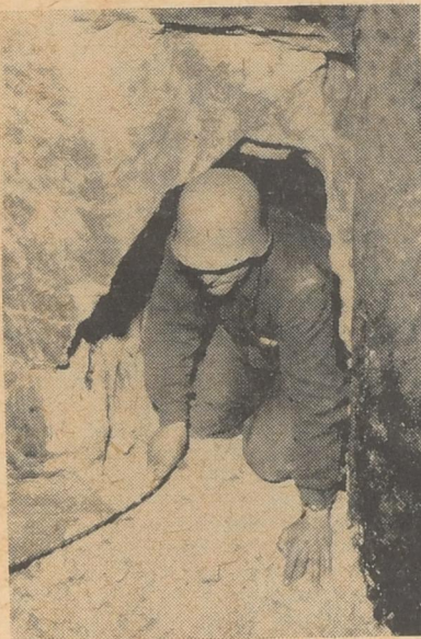
Dieses Loch wurde von den THW-Männern aus dem Sandstein geschlagen, um in den letzten Kellergang zu gelangen.
