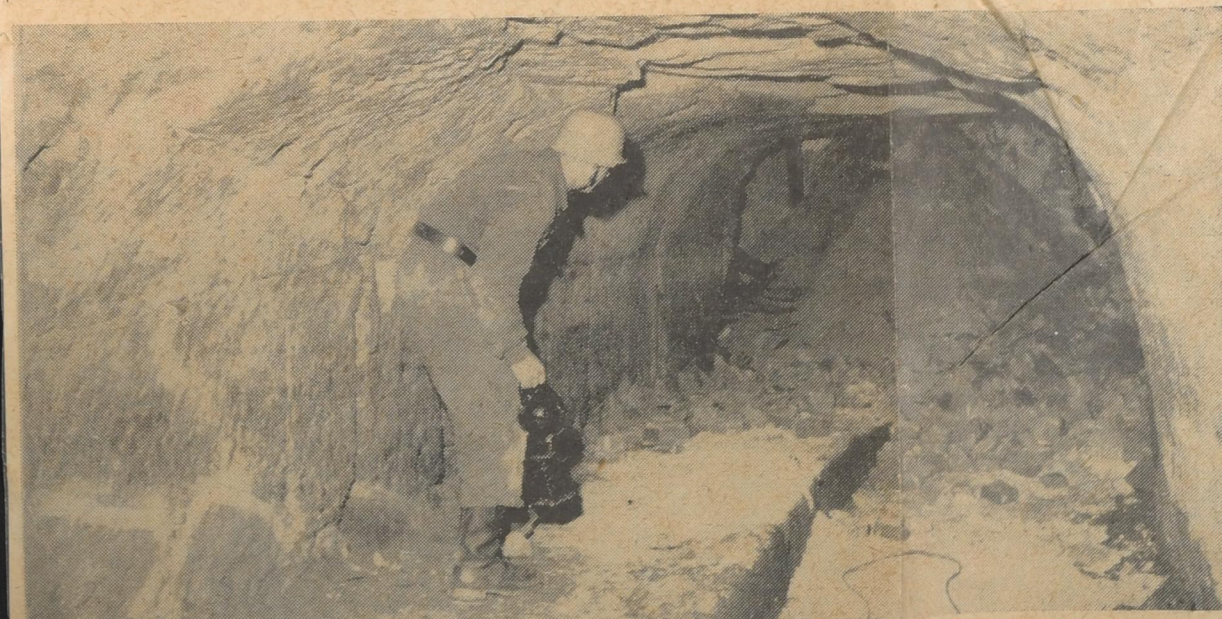
Hier wehrte der Einbruch der Bombentrichter-Geröllmassen den THW-Männern weiteres Vordringen
